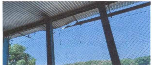
Foto 4: Reparación de bajada de agua pluvial
