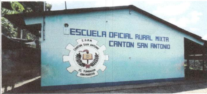
Foto1: pintura de muros interiores y exteriores
