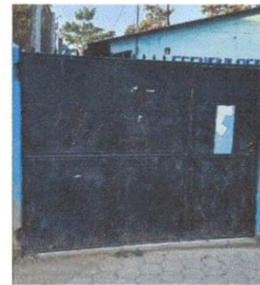
Foto 6: reparación de portón principal.
