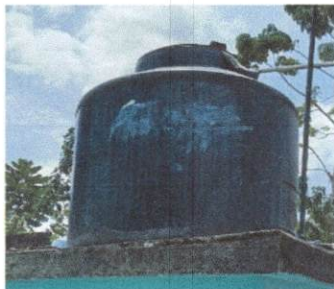
Foto 5: Sustitución de depósito de agua de 1100 lt
